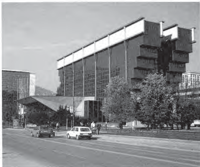
Slika 11: Zgrada Elektroprivrede nakon rekonstrukcije Image 11: Elektroprivreda building after the reconstruction
