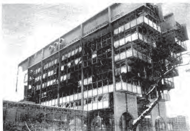
Slika 5: Srušena zgrada Elektroprivrede, Sarajevo Image 5: Demolished building of Elektroprivreda, Sarajevo
