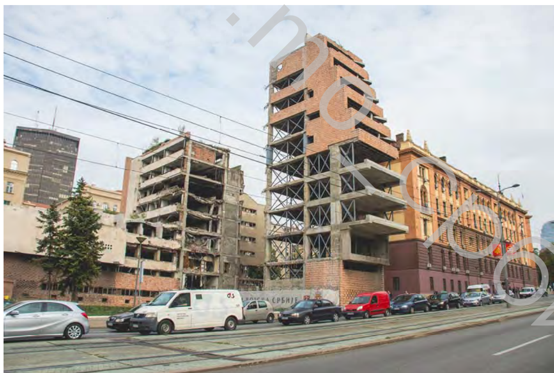
Фотографија објекта А, Јована Миловановић, јун 2016.
