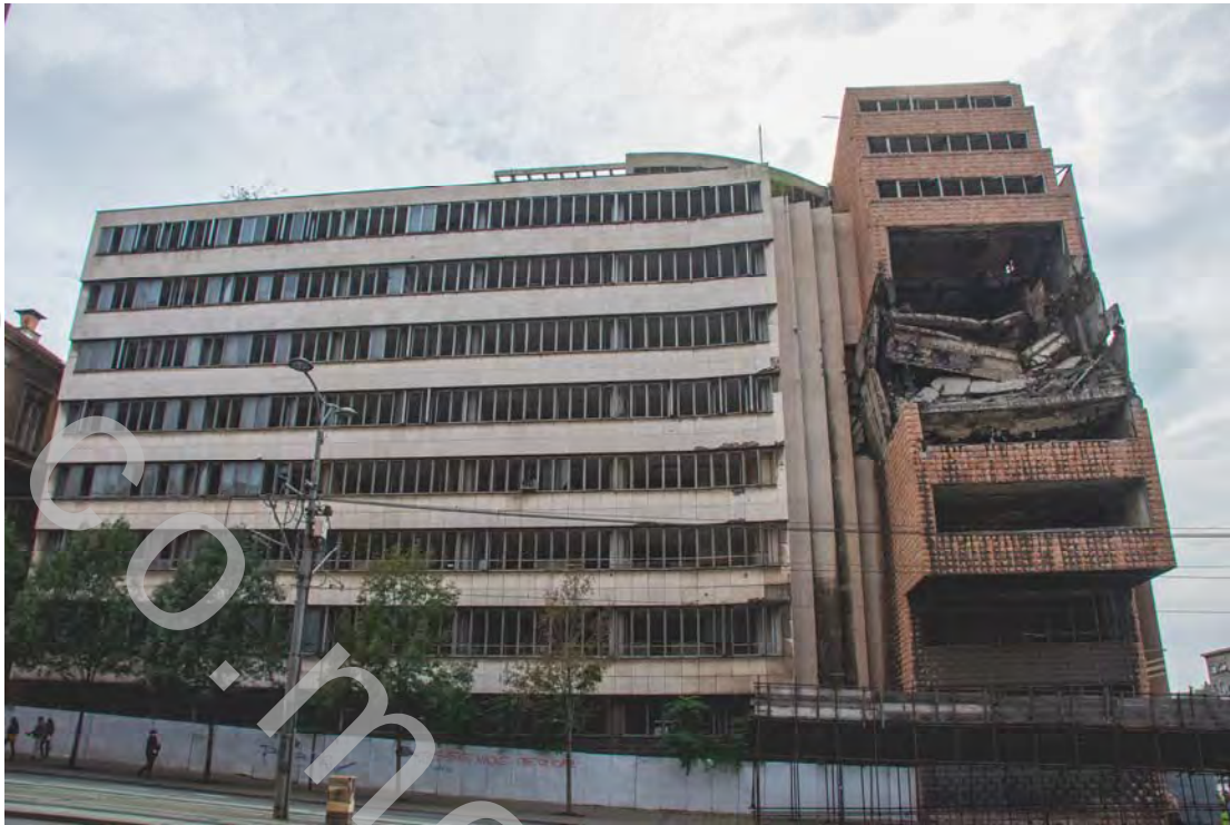
Фотографија објекта Б, Јована Миловановић, јун 2016.
